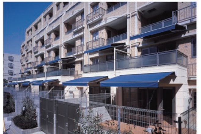
<当社ホームオーニングの施工事例です>
